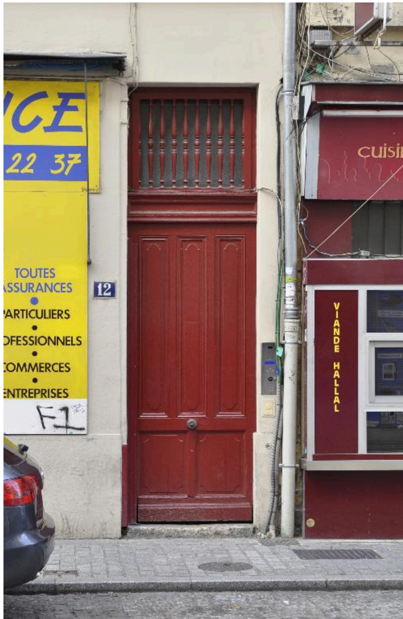
Vue rapprochée de la porte piétonne dotée d'une imposte à balustres de bois
