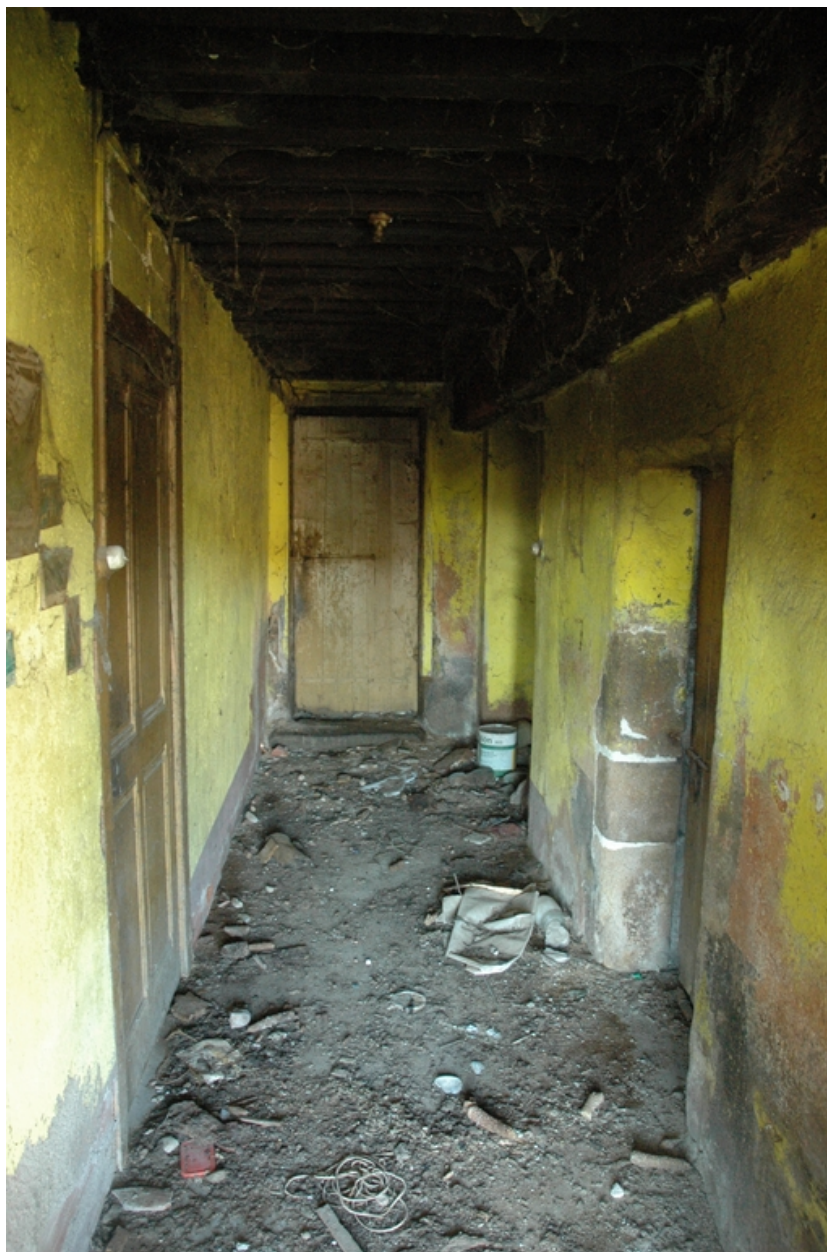
Vue intérieure du couloir traversant le logis au rez-de-chaussée, vers l'ouest.
