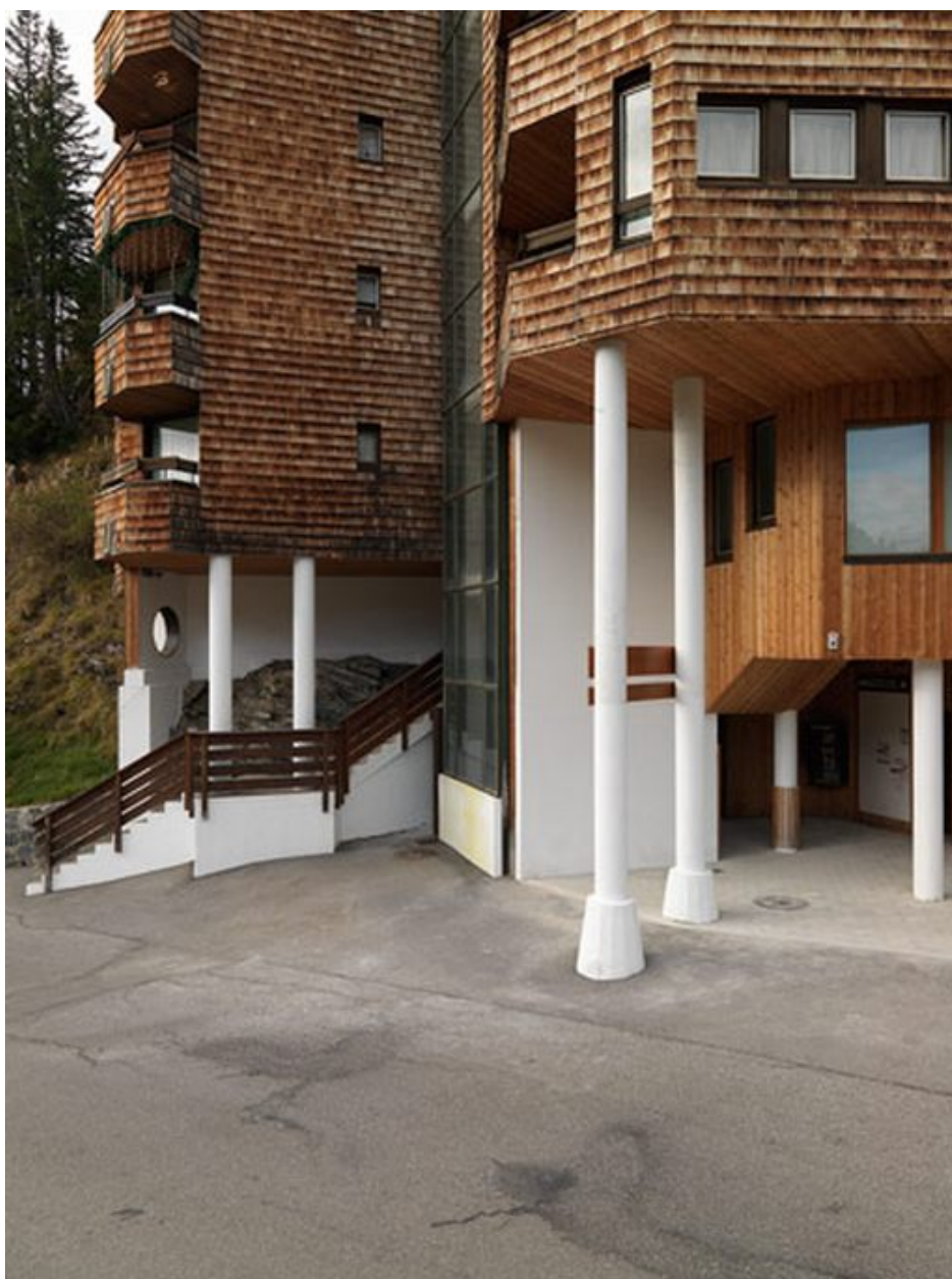
Entrée sud de la résidence et ascenseur public
