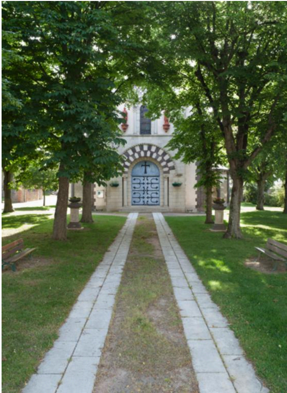
Vue du portail occidental.
