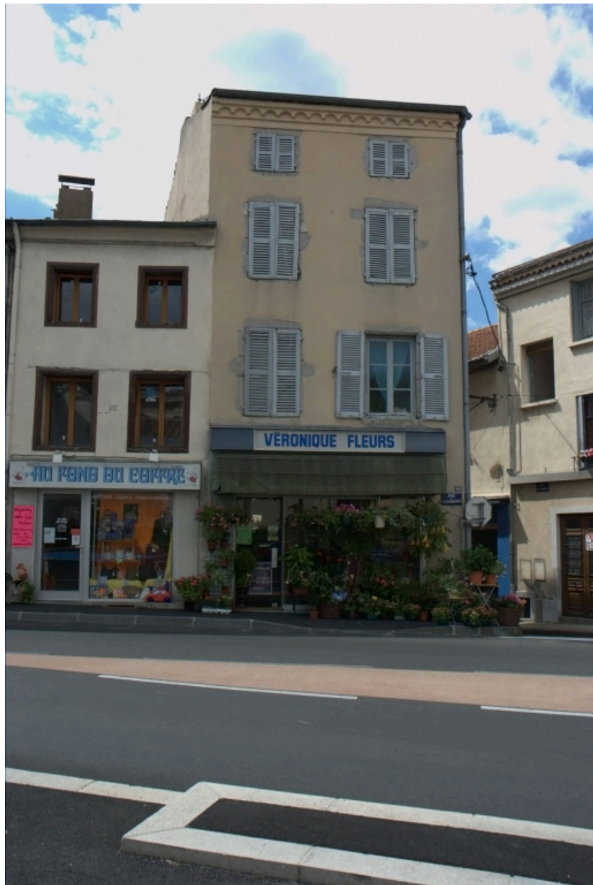
Îlot 5. Clermont (rue de) 48. Vue générale de la façade sur rue.
