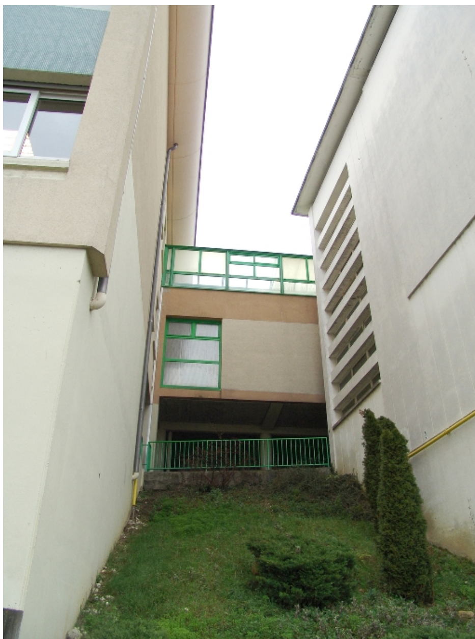
Jonction entre les deux bâtiments
