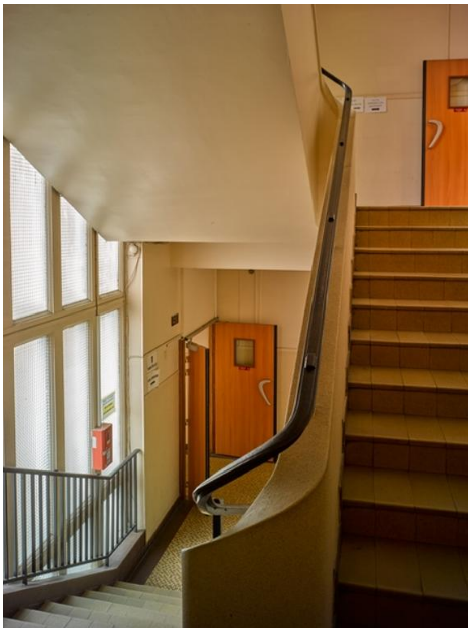
Bâtiment Carnot, cage d'escalier la plus à l'ouest, accolée au hall d'accueil.
