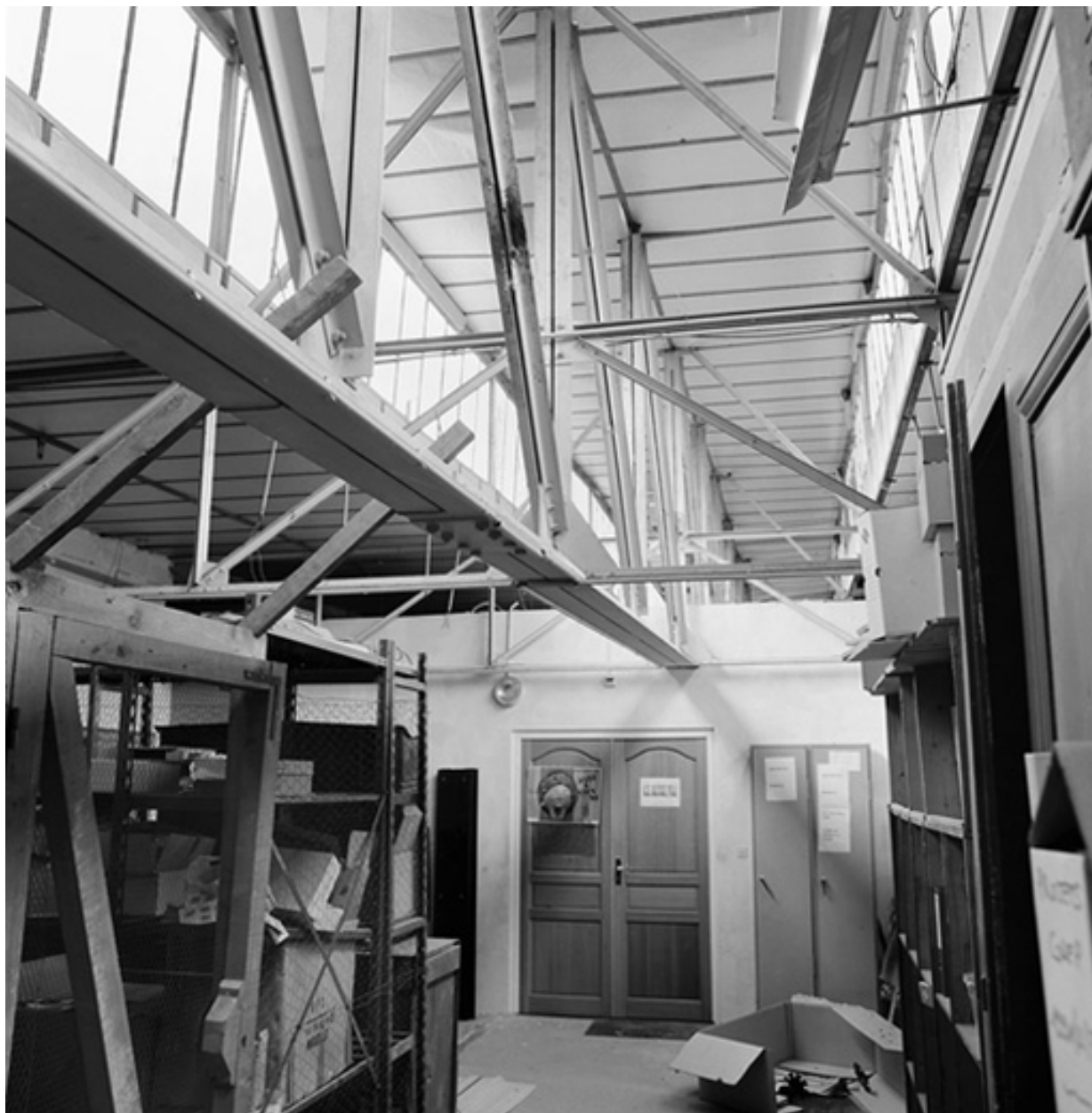
Vue intérieure charpente
