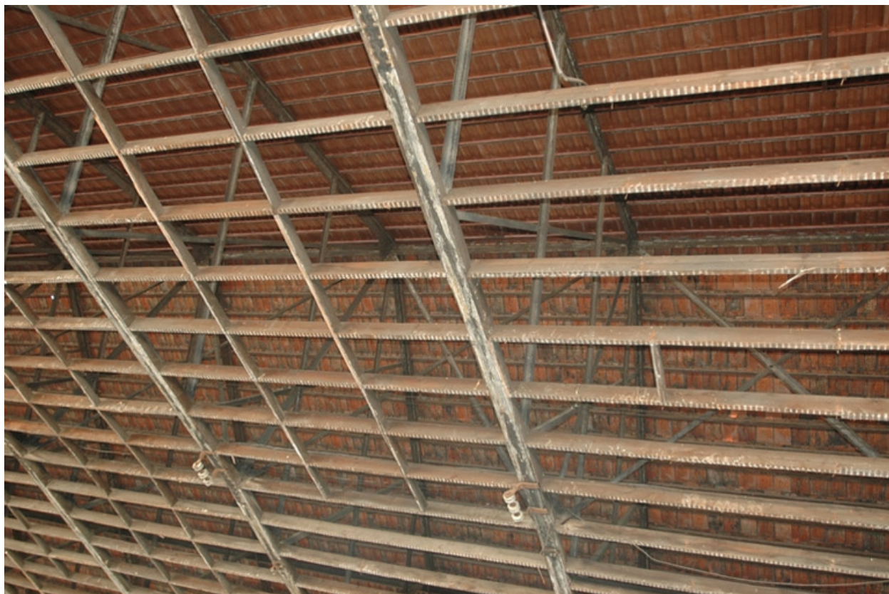
Détail charpente de la grande halle
