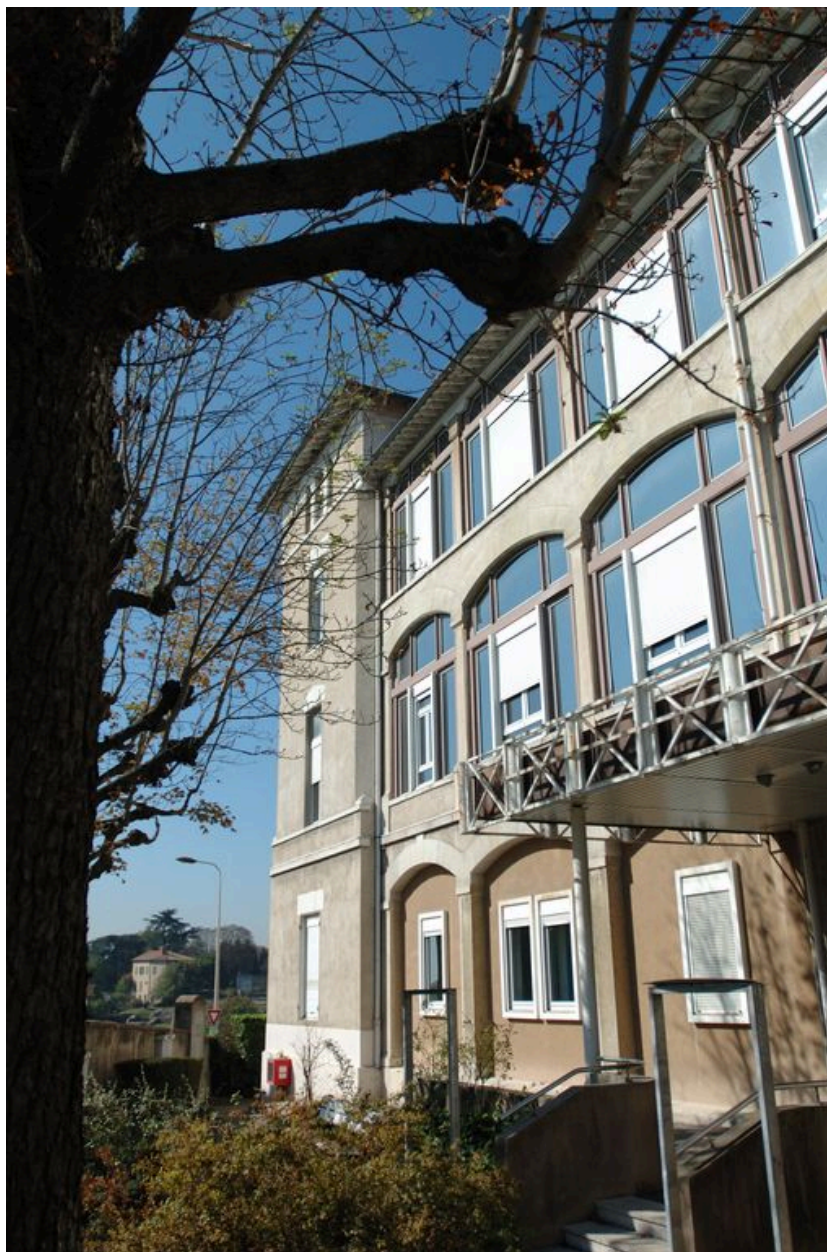
Vue de l'ancien bâtiment des malades, depuis la cour, côté rue Radisson (élévation est), en octobre 2011.
