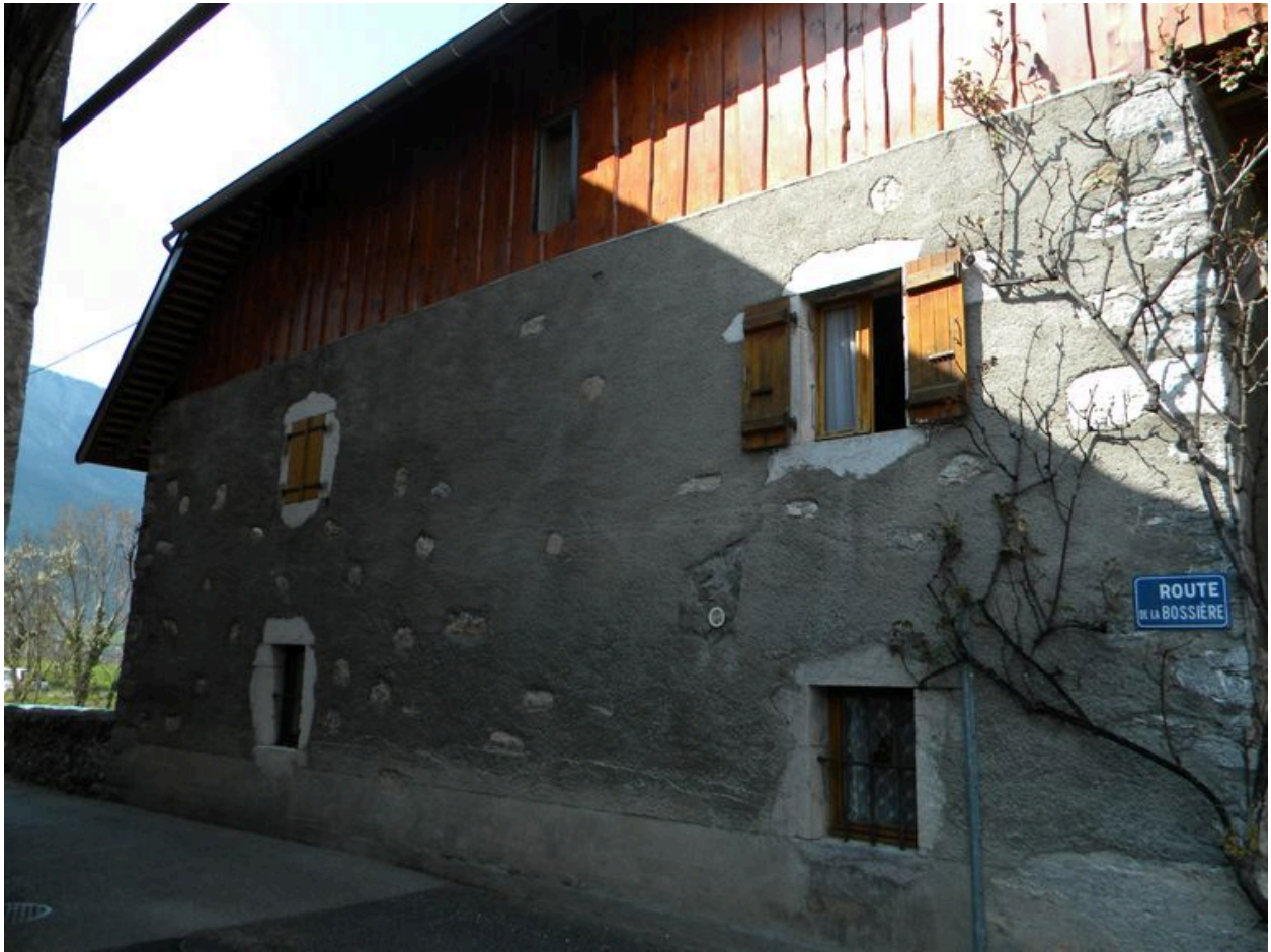
Vue du mur sud.
