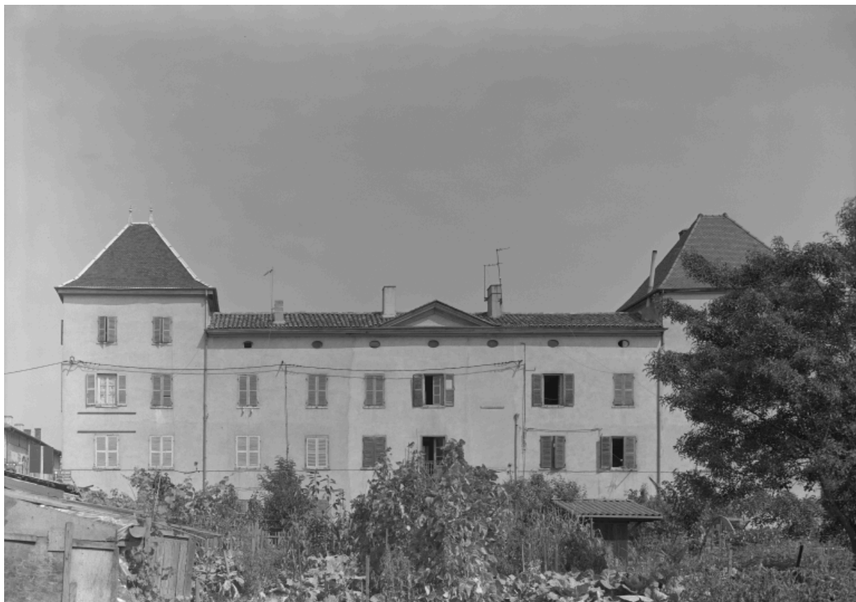
Elévation postérieure sur jardin.
