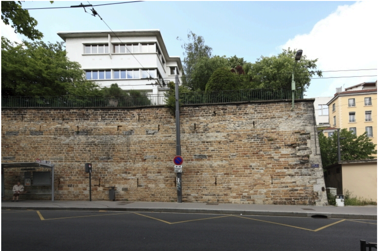
Mur de soutènement sous la maison du Directeur.
