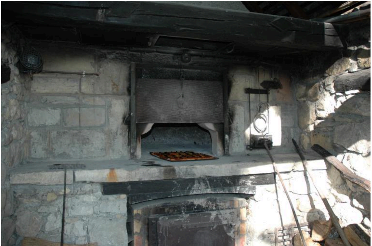
Détail de la bouche du four.
