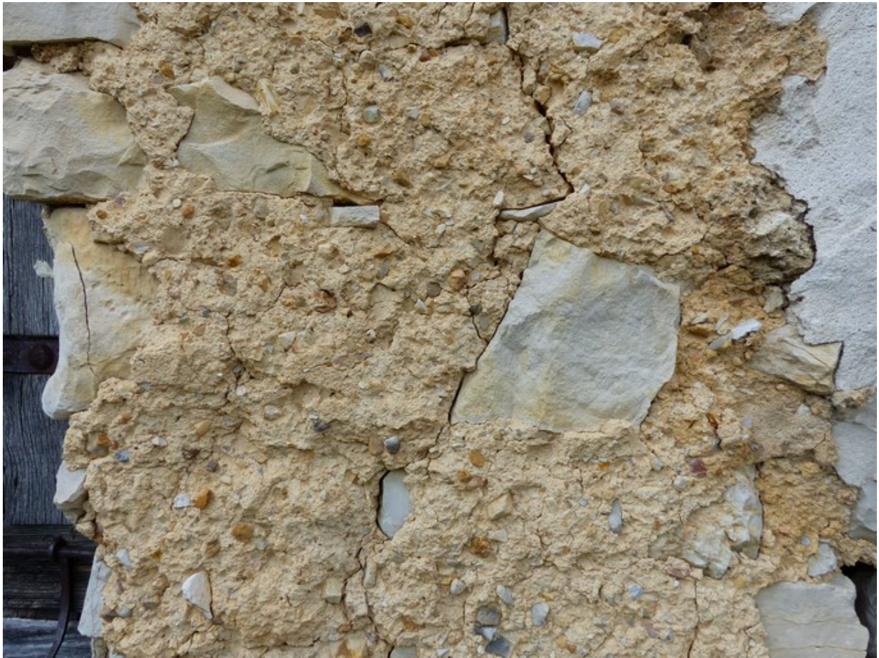
Pignon sud, détail de l'enduit rustique.
