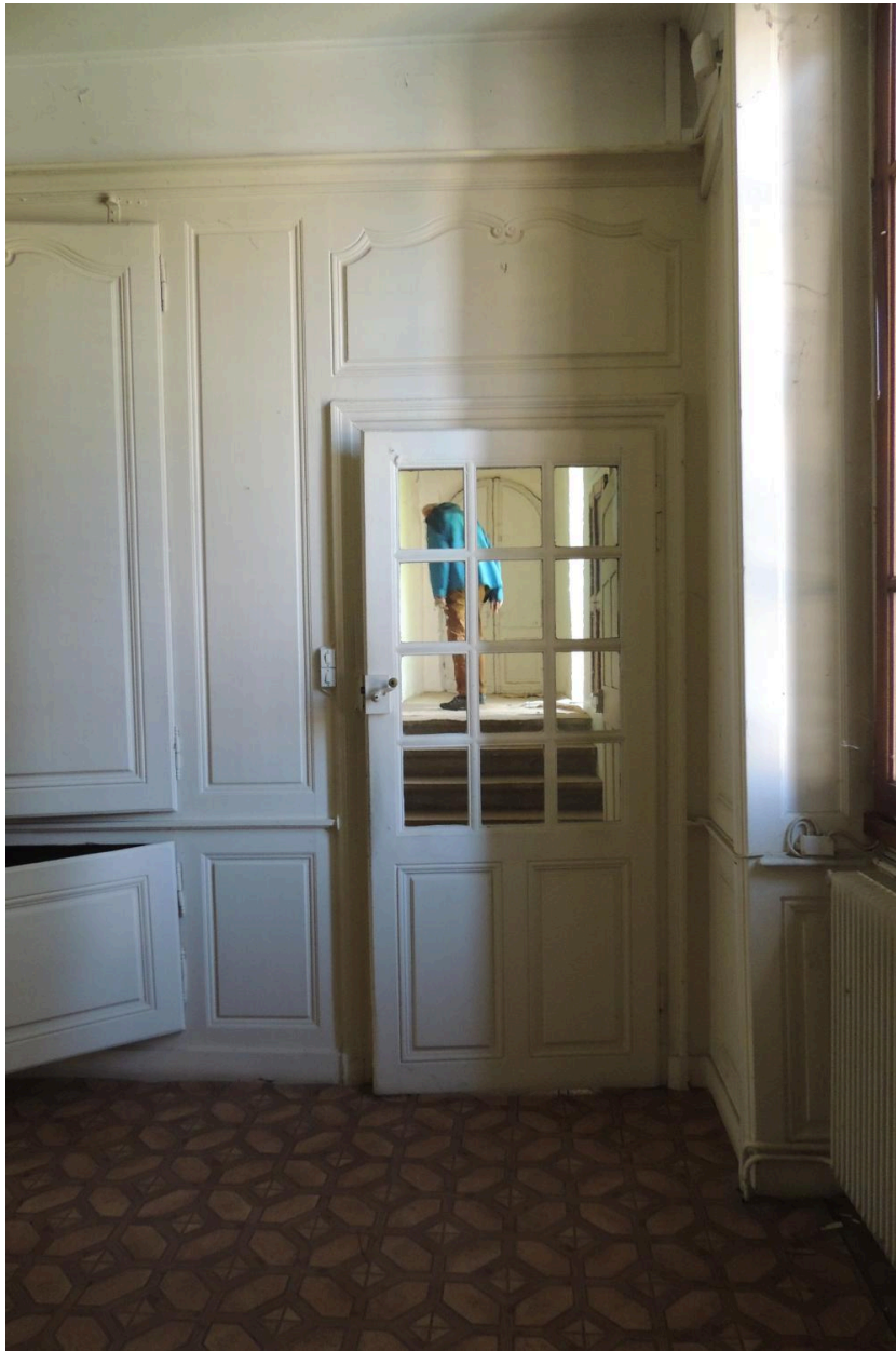
Palier, salle des archives : porte d'accès à imposte.
