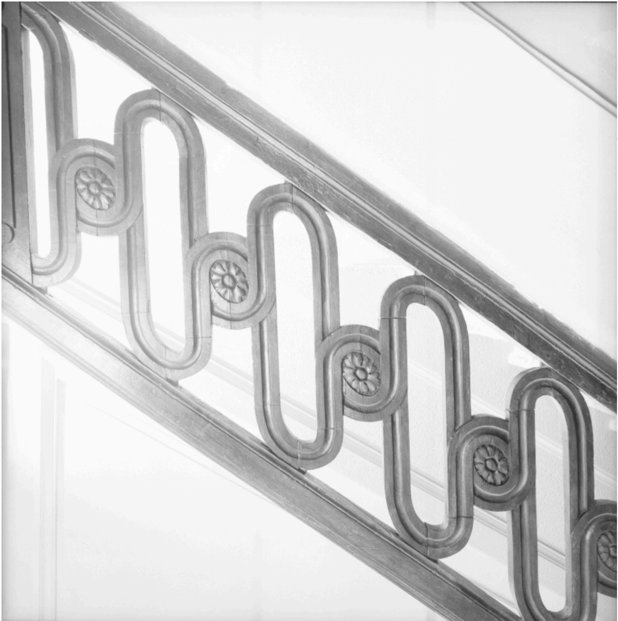
Détail du garde-corps de l'escalier.
