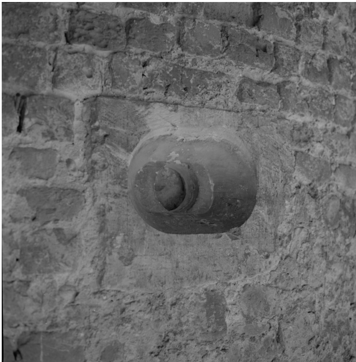
Détail, canonnière au 1er niveau de la tour.
