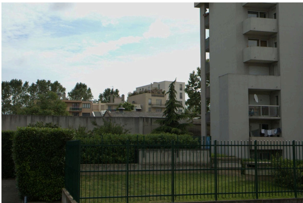
Vue sud des toits en coeur d'îlot du n° 10
