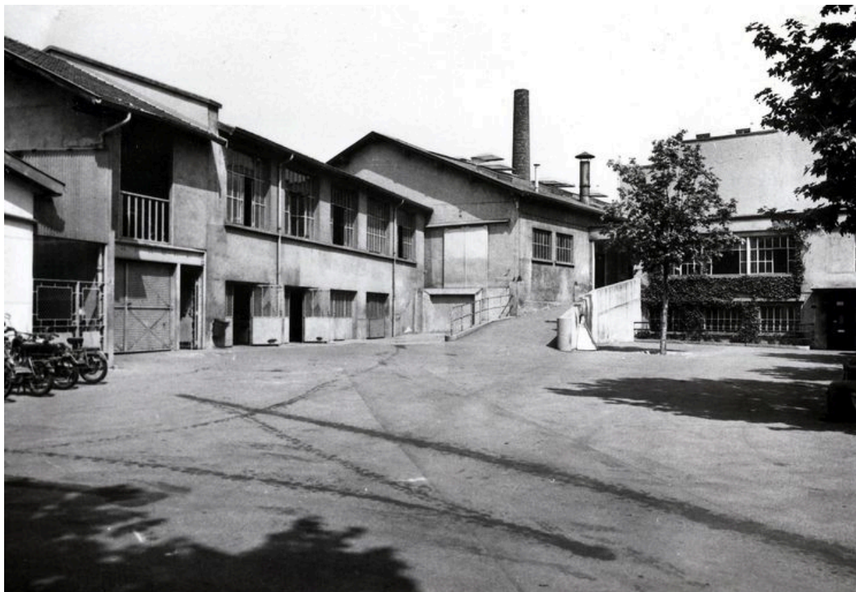
Bâtiments dans la cour : parc à bois, modèlerie et fonderie, 1975
