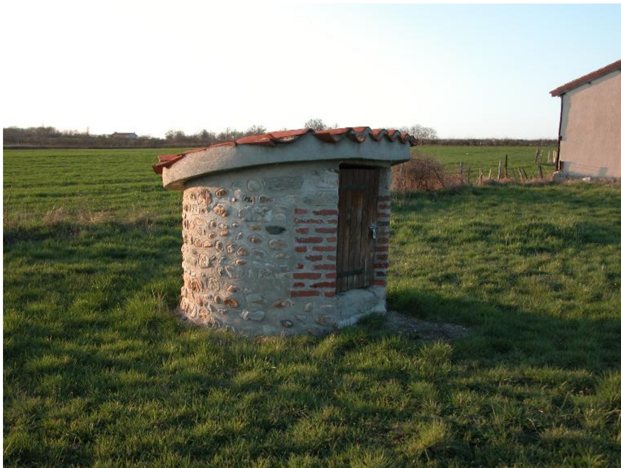
Vue d'ensemble du puits "casquette" situé au-devant de la ferme.
