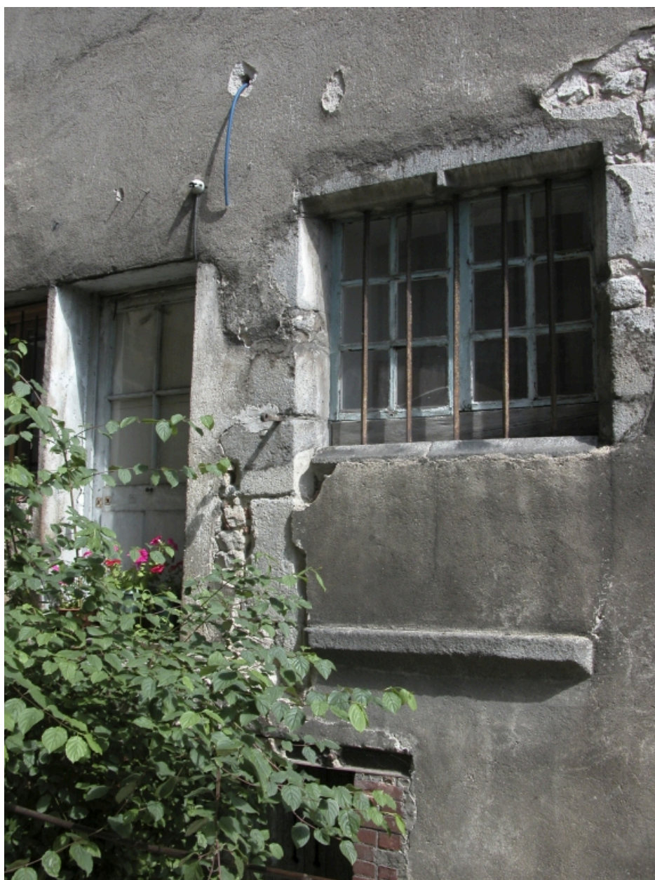
Îlot 2. Roanne (rue de) 13, 15. Vue partielle de la façade sur cour.
