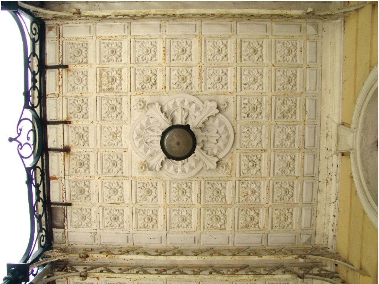
Plafond à caissons du porche
