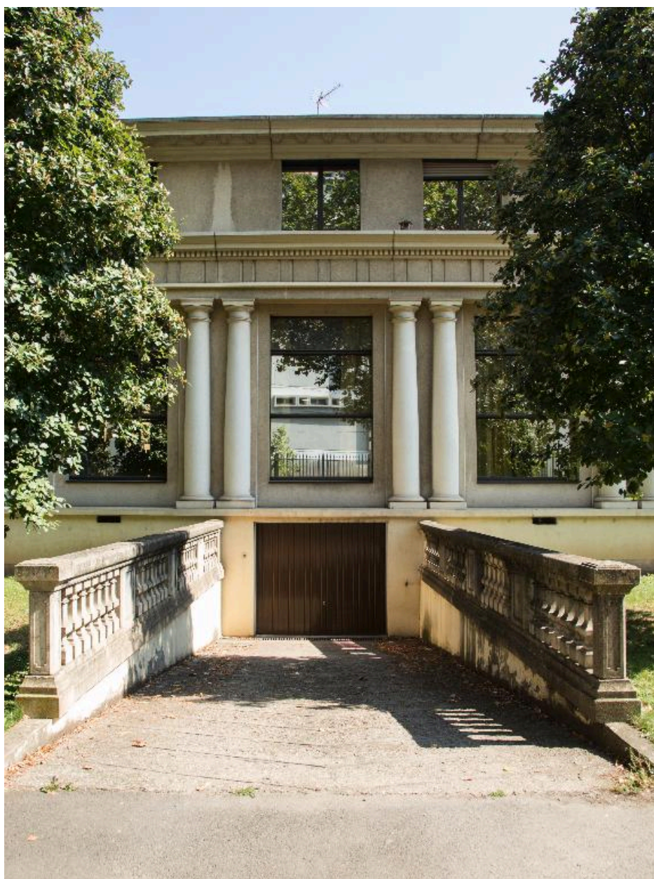
Détail de la façade vue du cours Hippolyte Sauzée
