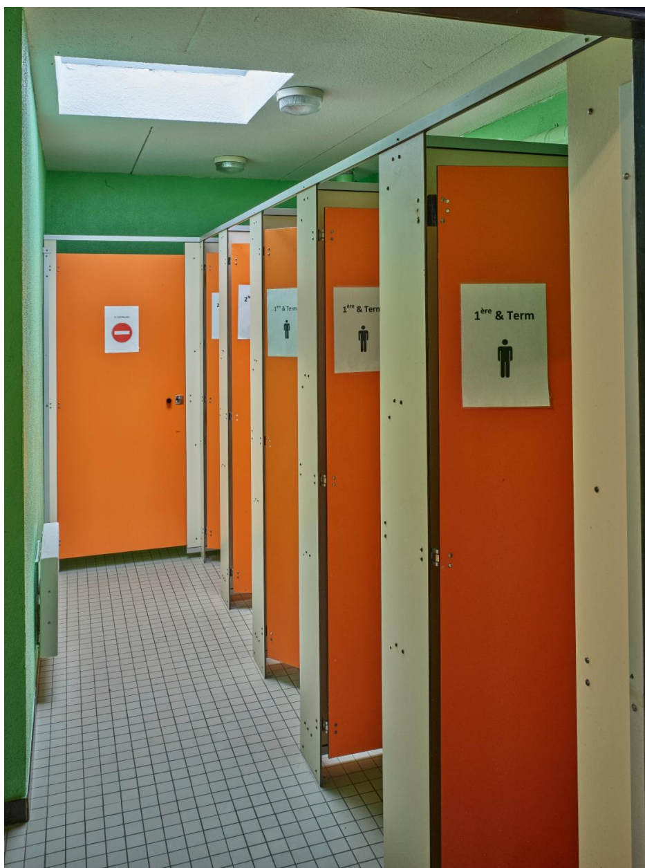
Bâtiment de l'internat. Sanitaires du dernier niveau (cf. éclairage zénithal), aile est. Cabines préfabriquées.
