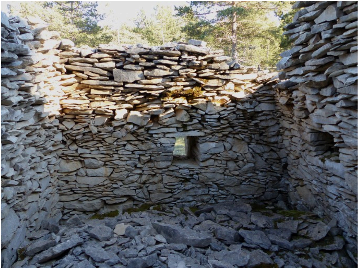
Cabane sud. Vue de volume prise de l'ouest.
