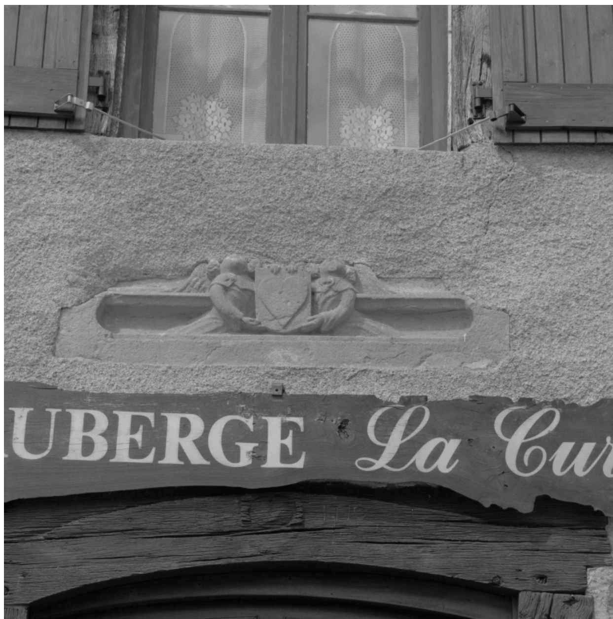
Elévation antérieure, détail d'un élément sculpté réemployé au-dessus de la porte d'entrée.
