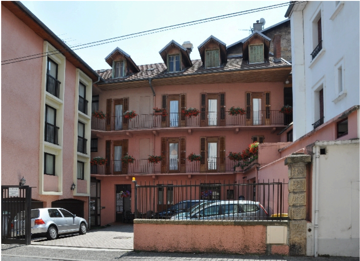
Façades sur cour
