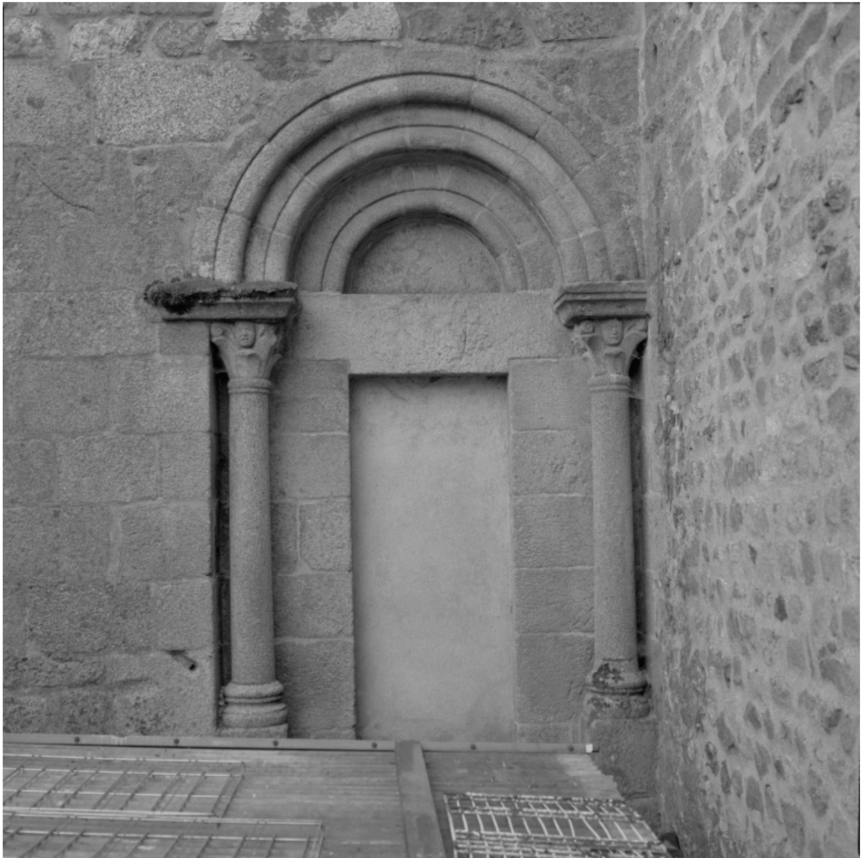
Vue de la porte murée du transept nord.
