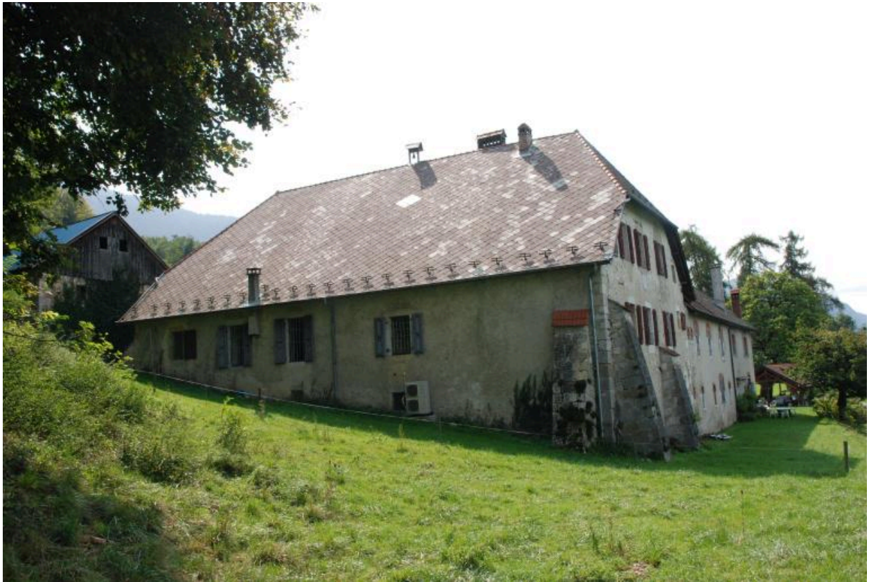
Vue d'ensemble de trois-quarts nord-ouest du corps de logis.
