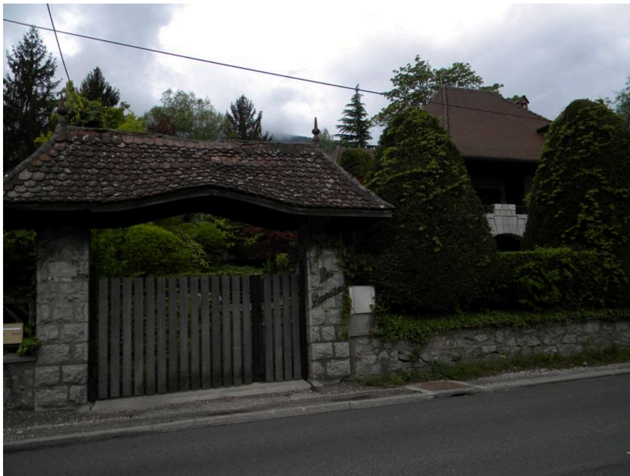
Façade et porche d'entrée d'une villa.
