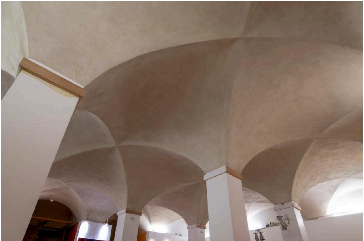
Salle voûtée d'arêtes, détail
