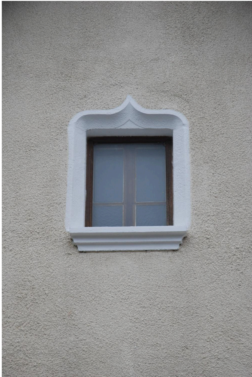
Maison (non repérée, 2017 B52 2629). Fenêtre à accolade en remploi.
