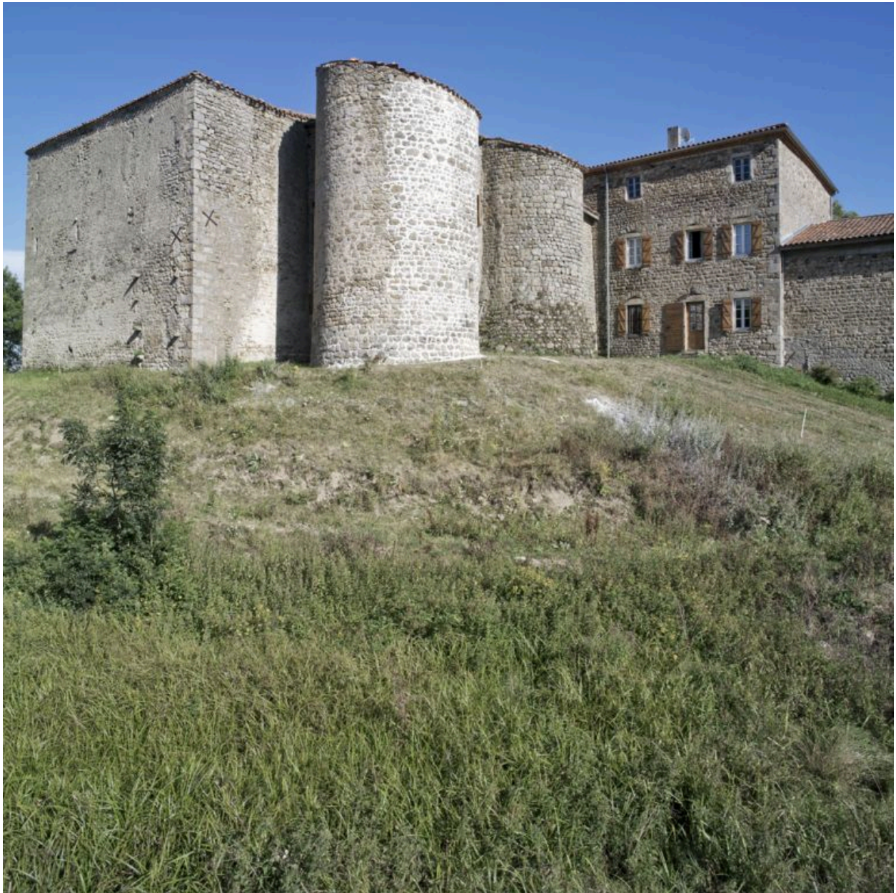
Vue d'ensemble de la maison forte depuis le nord-est.
