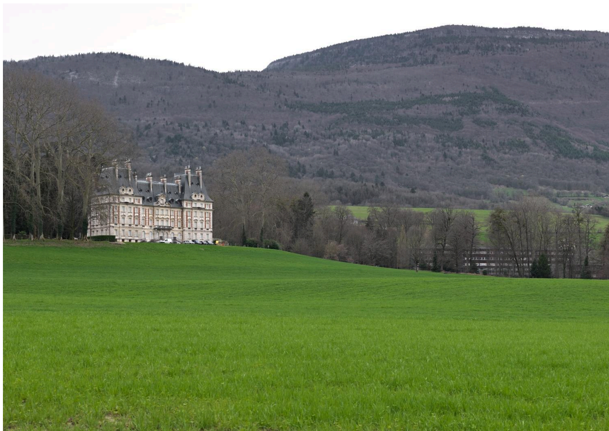
Vue d'ensemble de l'ancien bâtiment (façade arrière) et vue sur le parc.
