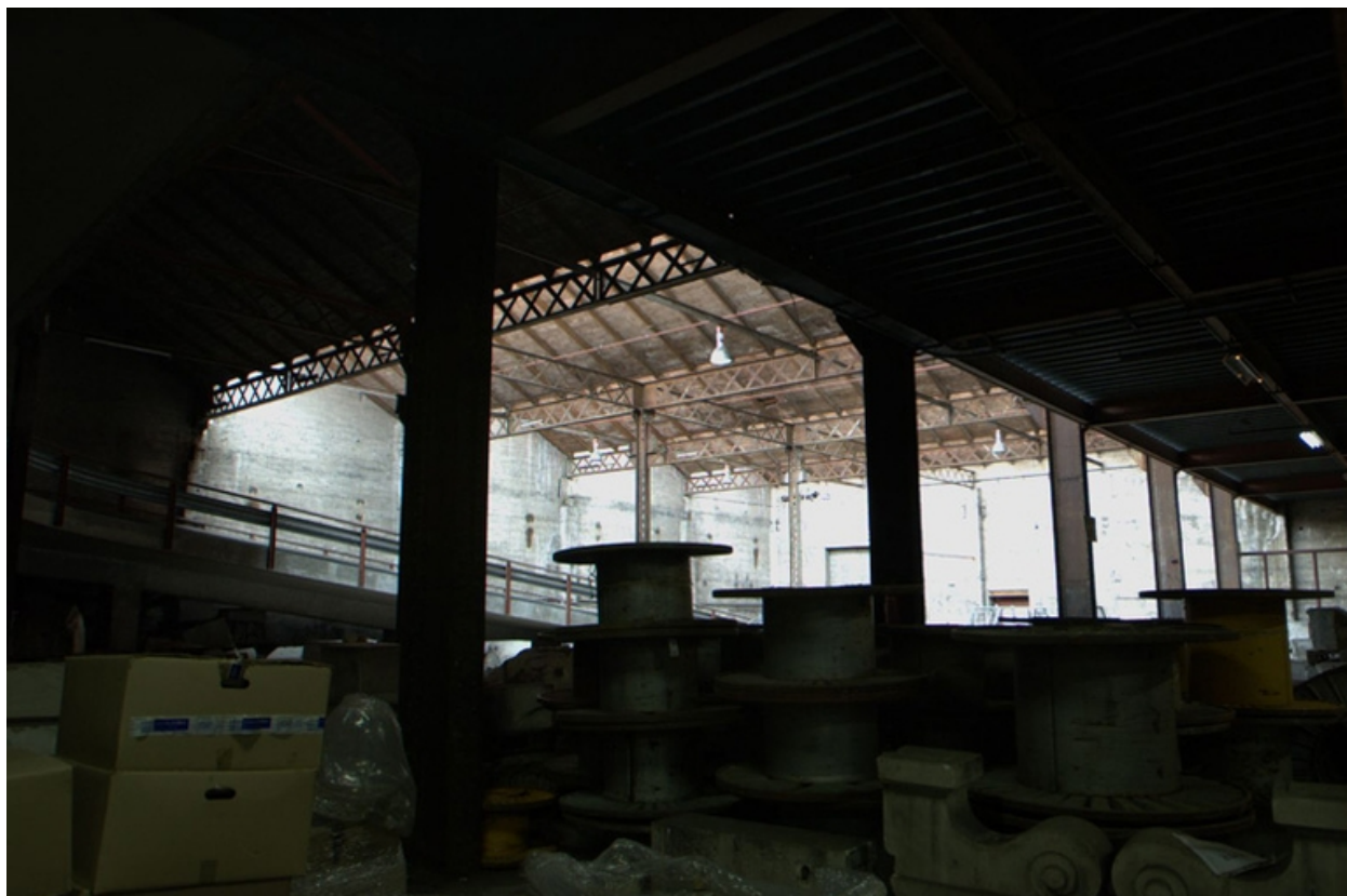
Vue de la rampe construite en 1960 par la fourrière municipale
