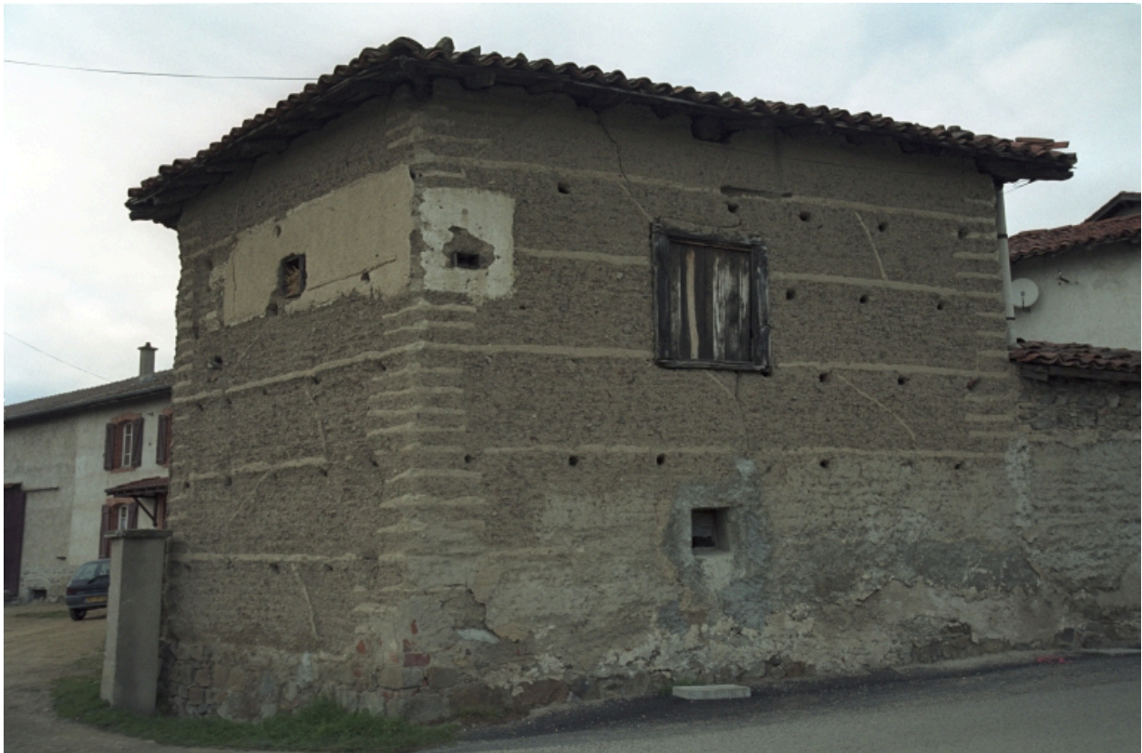
Pigeonnier aménagé dans un bâtiment de ferme (logement) à Saint-Sixte, le bourg (1987 A1 117).
