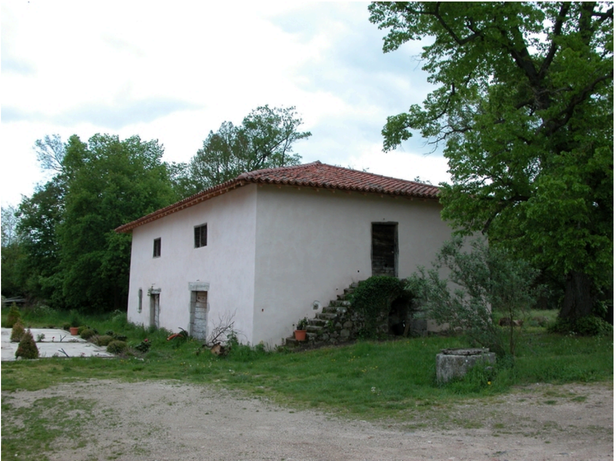
Vue de la grange-étable, depuis le nord-ouest.
