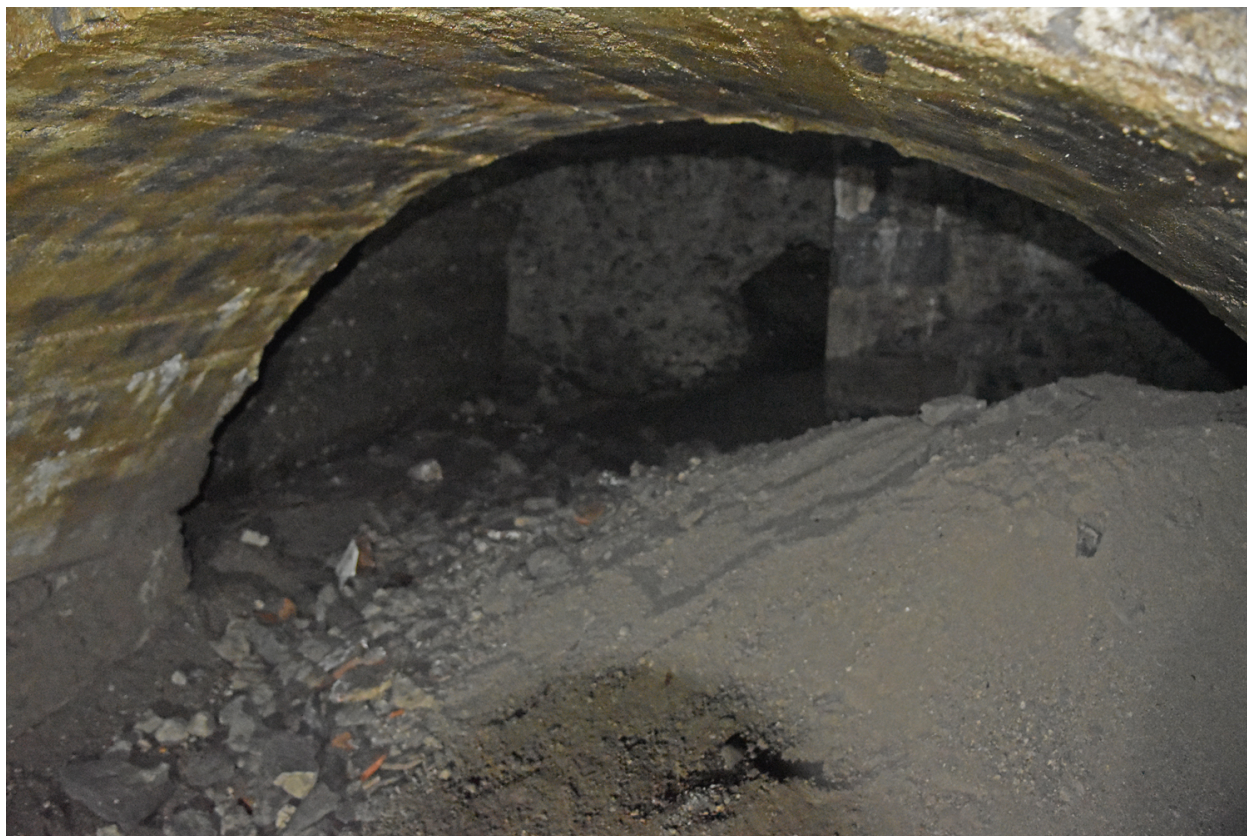
Caves nord : cave non relevée située au niveau -2, vue depuis le nord
