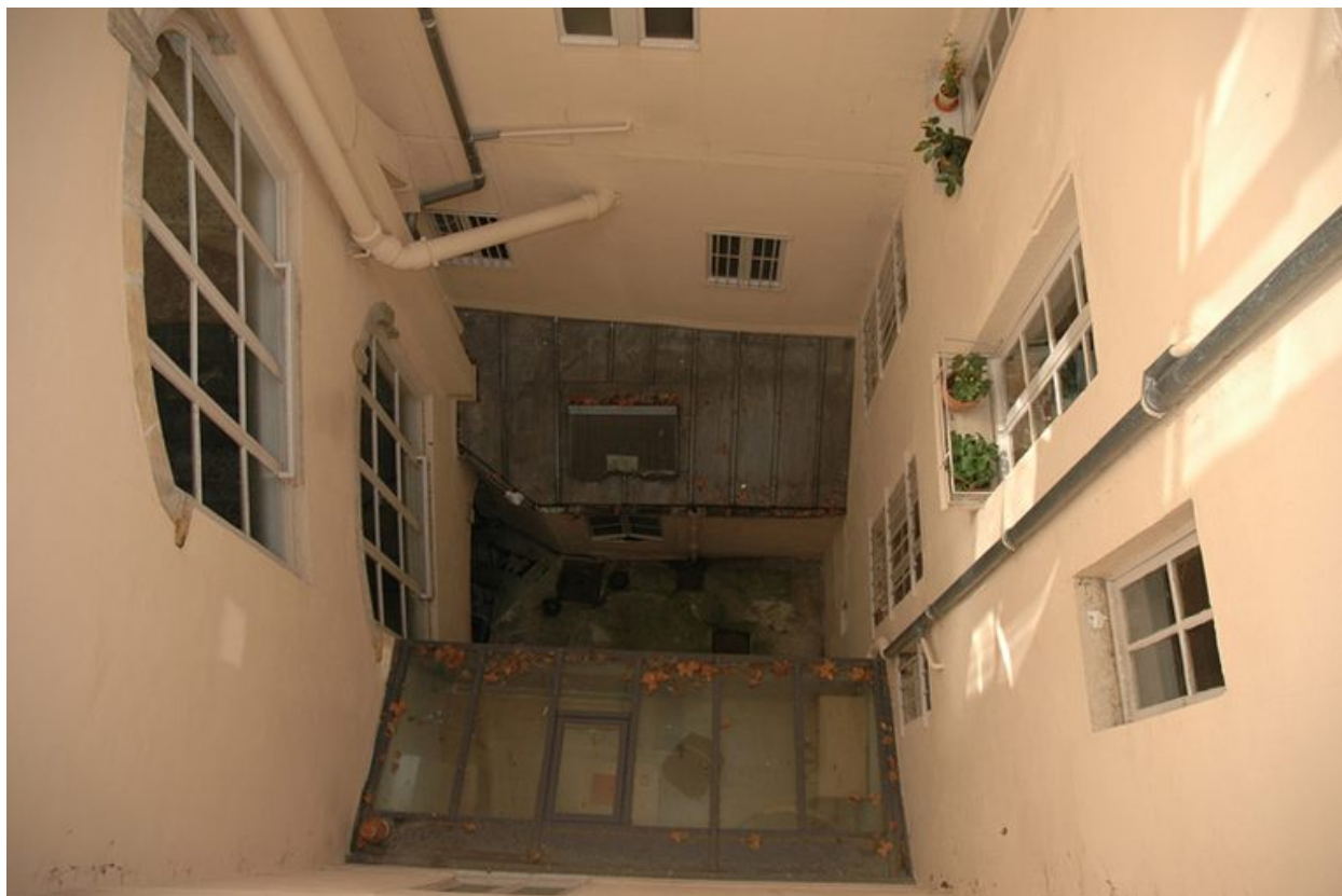
Couvent : 12 place Antonin-Gourju, vue en plongée de la cour de l'immeuble
