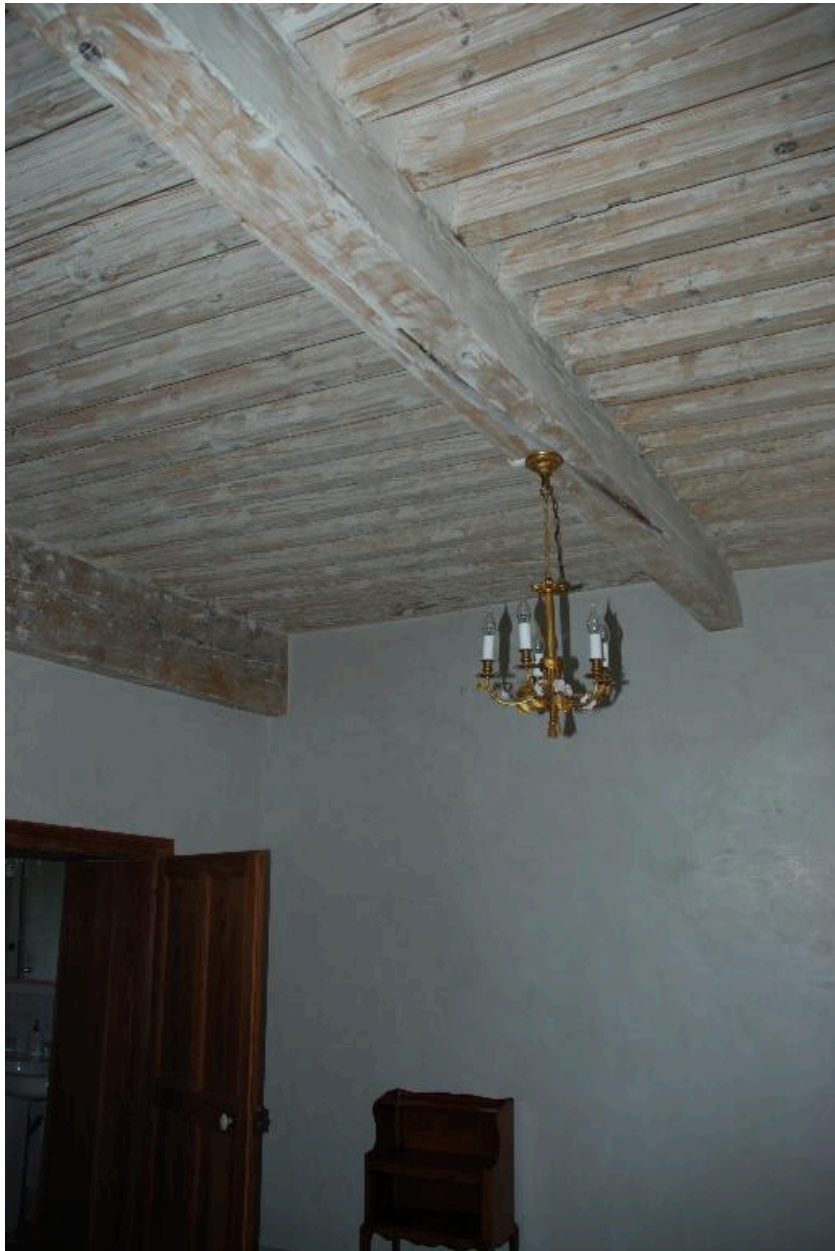
Deuxième étage. Plafond d'une des deux chambres situées au nord-est
