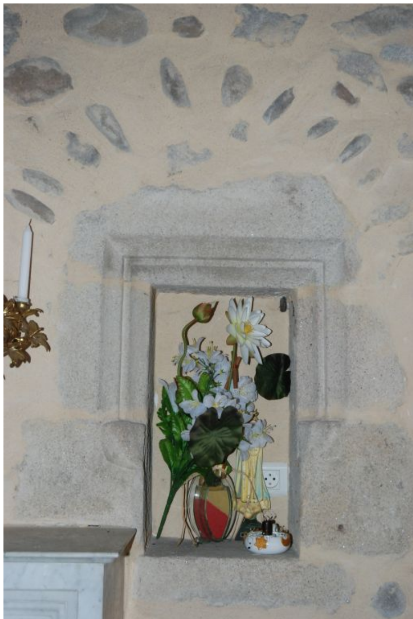
Détail de la niche de la chapelle nord.
