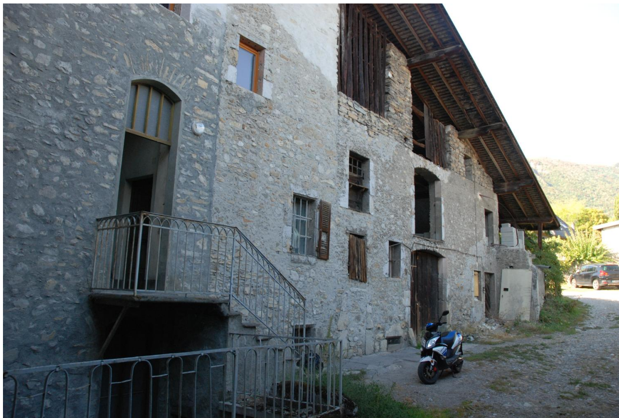
Maison, immeuble, 48 à 58 rue Louis Blanc-Pinget (2018 E1 350). Bâtiment sur cour. Granges-étables.
