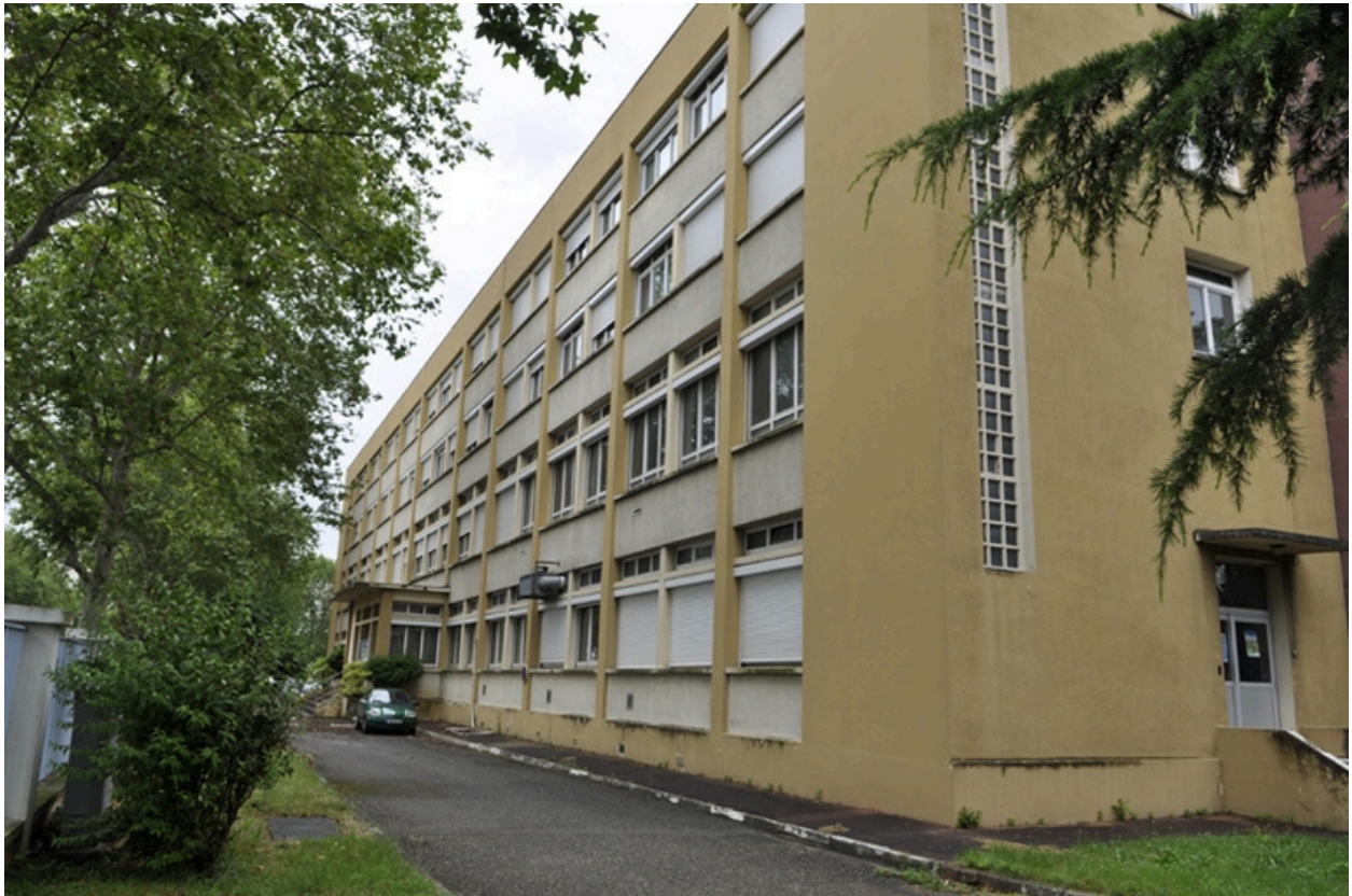
Bâtiment des années 70 abritant le musée d'histoire militaire de Lyon : façade nord.
