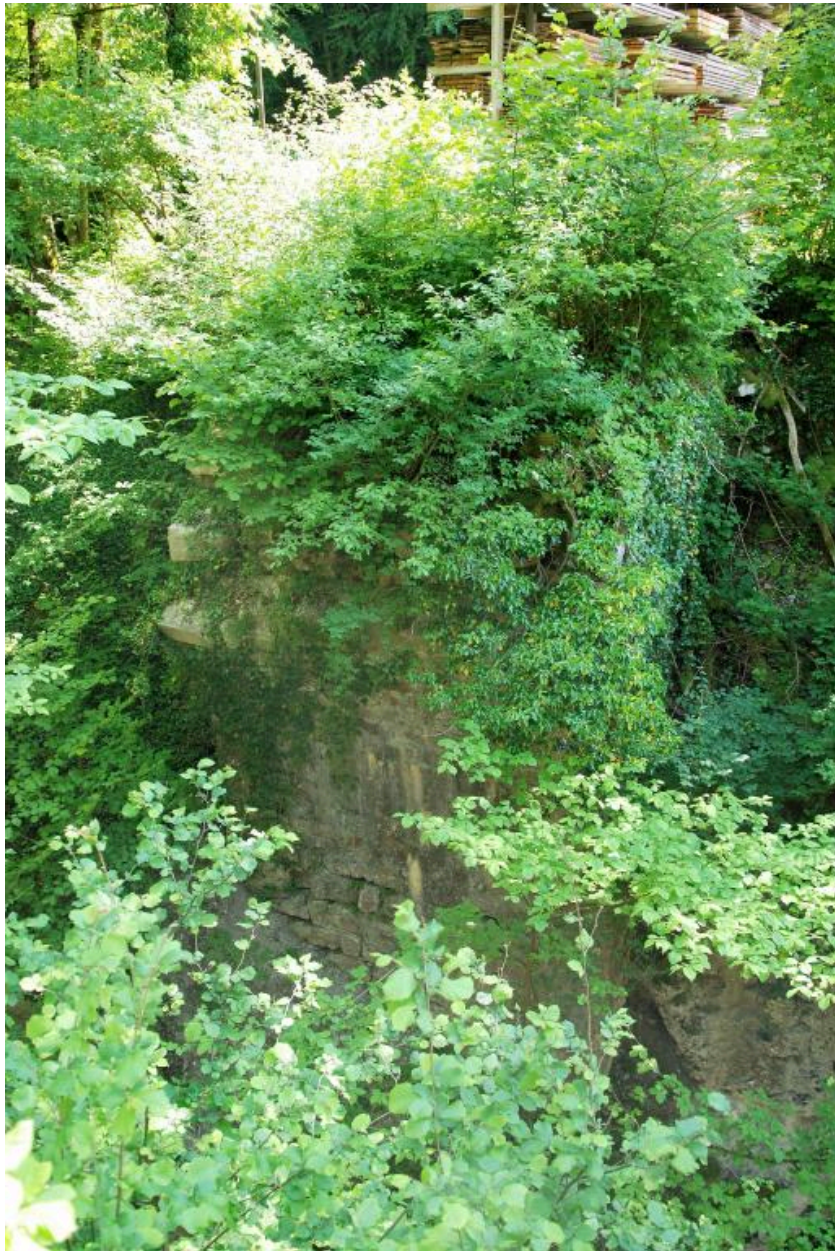
Vue de face d'une culée de l'ancien pont.
