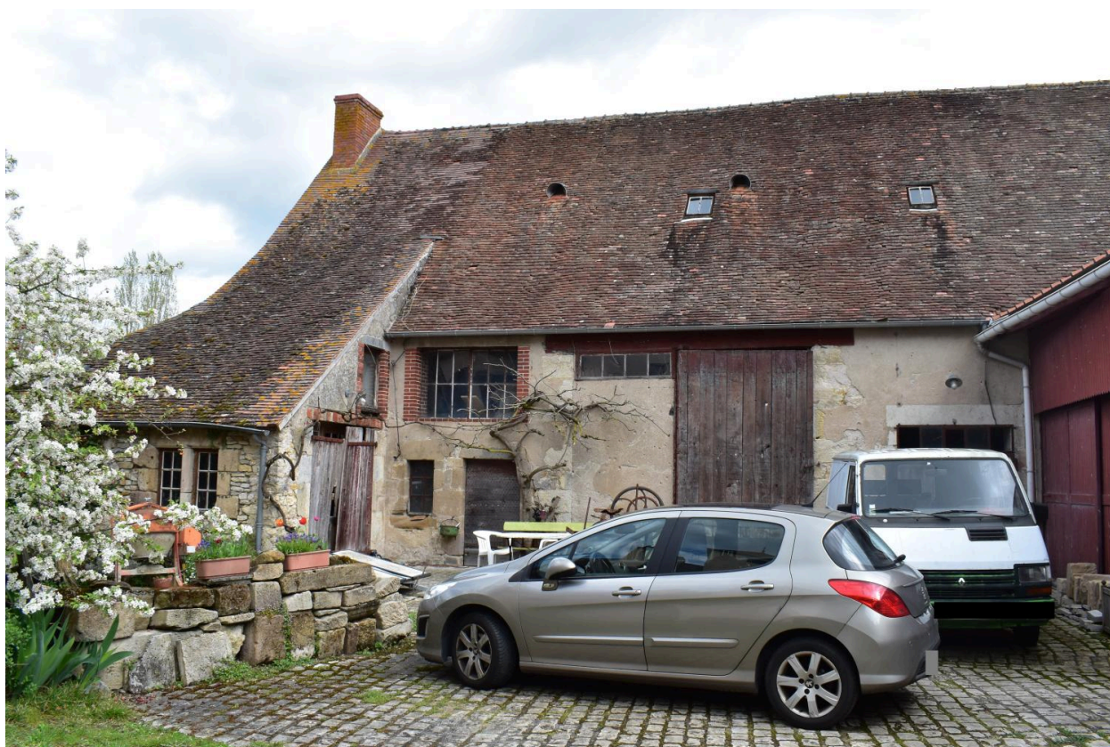
Vue générale des communs.
