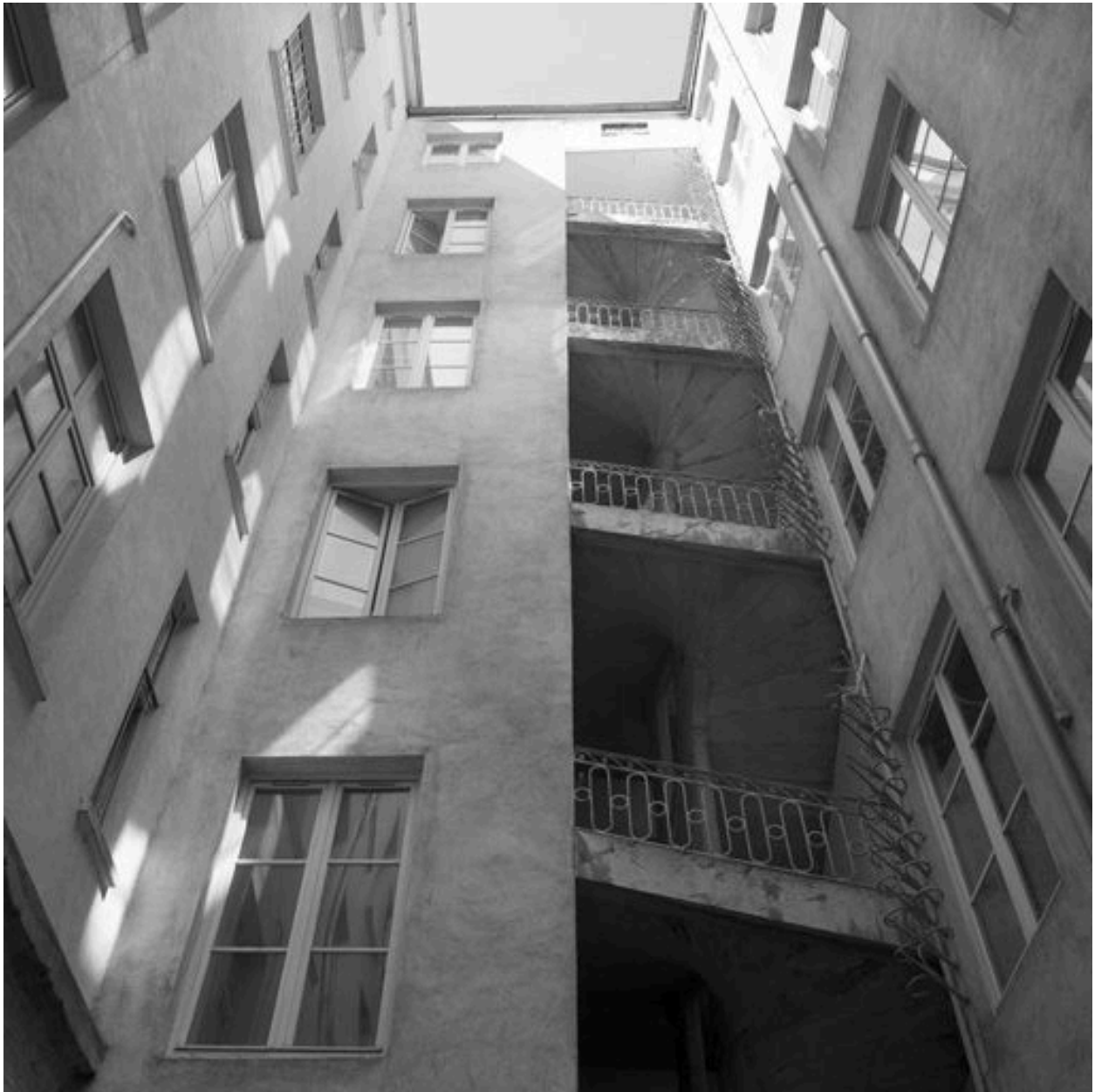
Deuxième cour, élévation du deuxième corps de bâtiment
