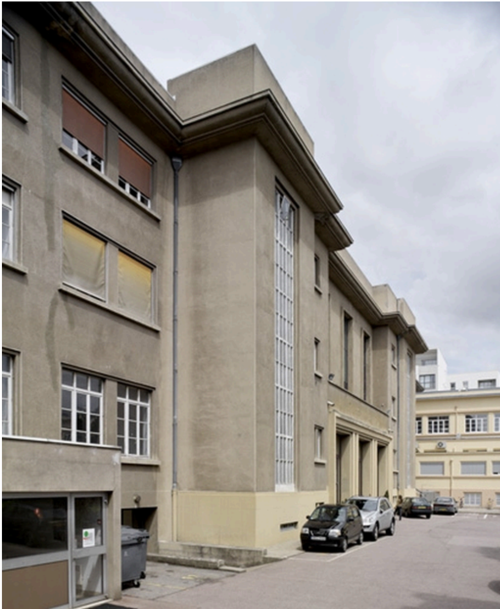
Façade est du bâtiment principal
