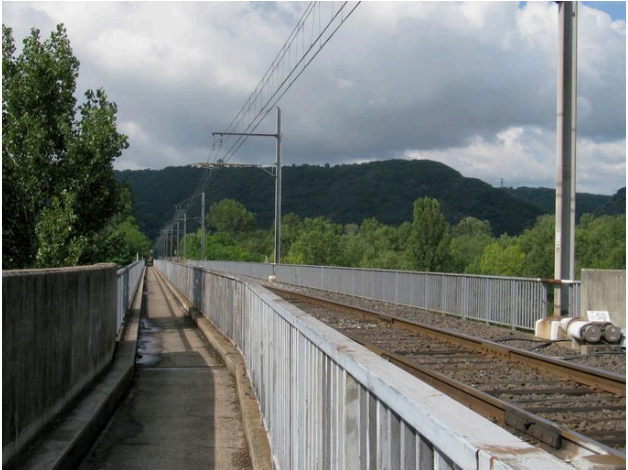
Voie piétonne et voie ferroviaire (depuis la rive gauche)
