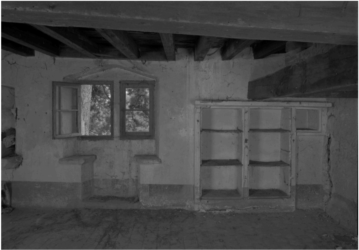
Salle du logis B, détail : fenêtre à coussièges et armoire de pierre.
